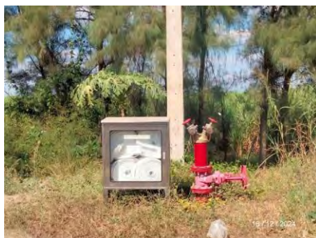
ภาพที่ 2.2-57 ระบบท่อน้ำดับเพลิงบริเวณลานกอง กากอ้อย
