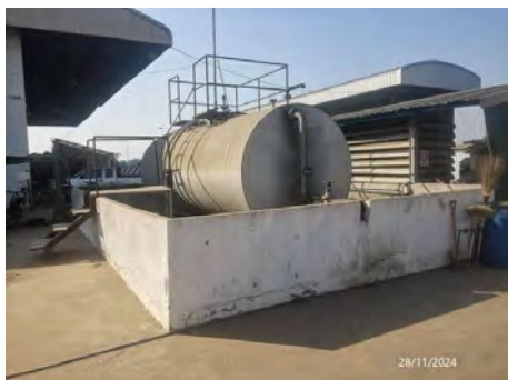
ภาพที่ 2.2-16 กำแพงกั้นถังกักเก็บน้ำมันโซล่า (Bound Wall)
