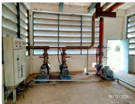
ภาพที่ 2.2-32 เครื่องสูบน้ำ
